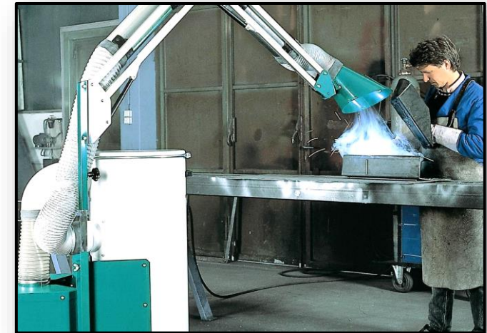
写真：溶接ヒューム回収
